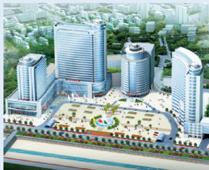
湖北十堰市医院变压地下室水泵
