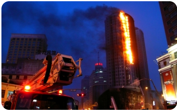
哈尔滨一大厦因消火栓泵老化造成重大火灾
