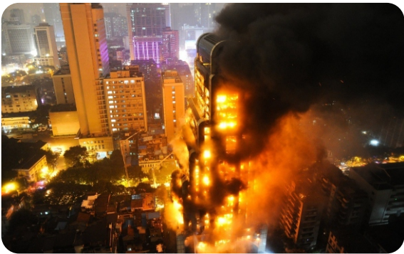
广州一大厦因水泵锈死导致大火燃烧10小时
