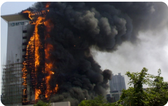
桐城一公办大楼因消火栓水压不够影响救援
