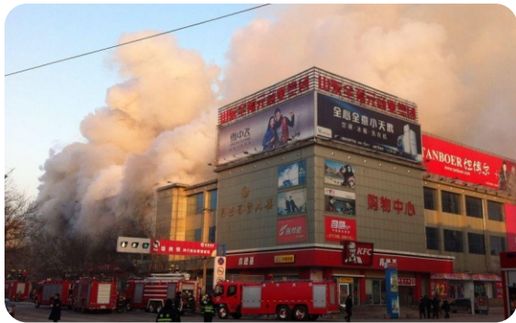
山东寿光一大厦因喷淋泵缺水影响救援
