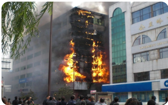
公主岭一办公大楼因消防泵老化影响救援
