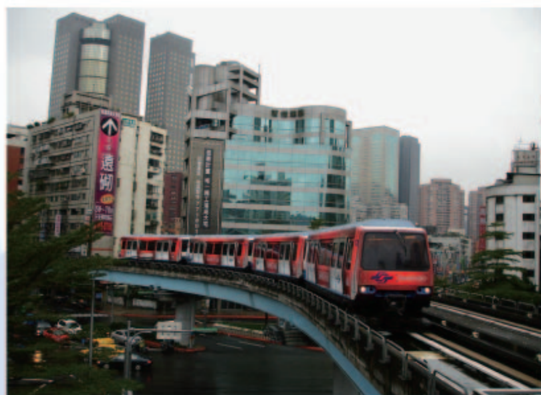
台北木栅线捷运工程
