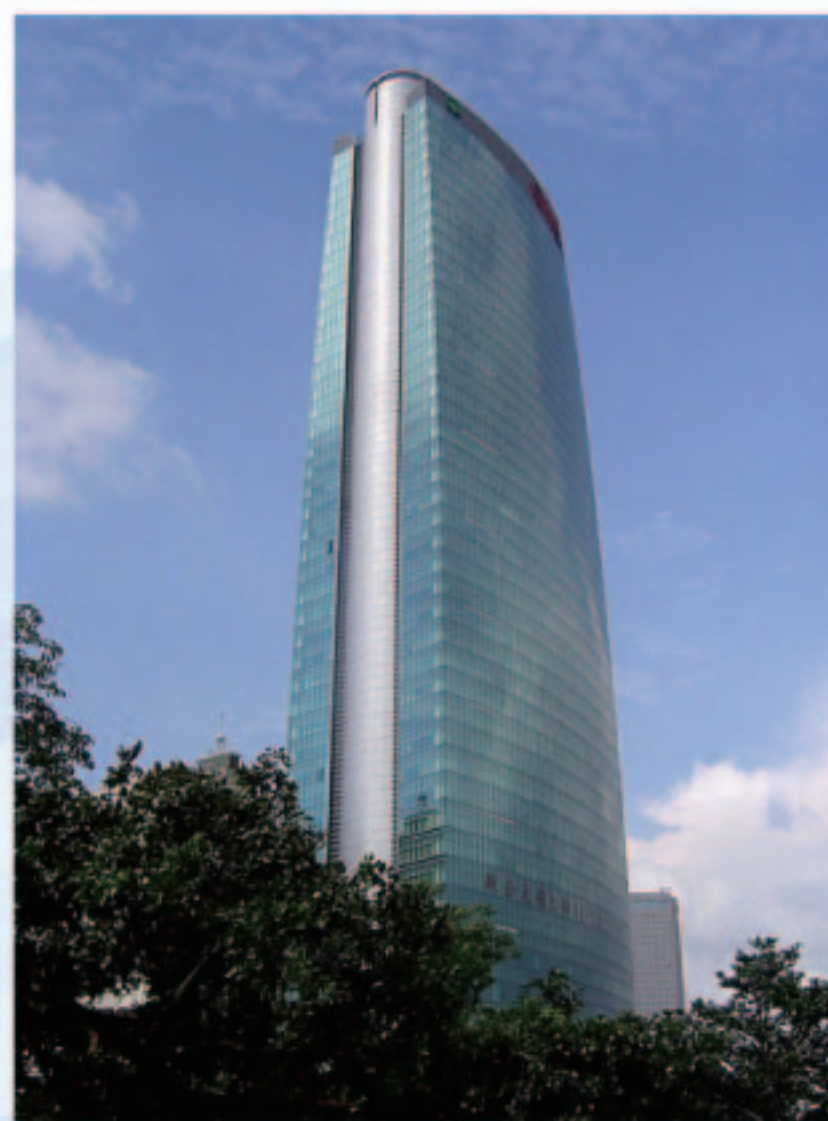
台中国泰金融大楼
