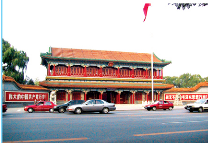
中南海变配电工程
