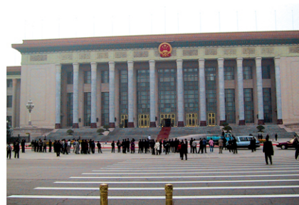
人民大会堂工程
