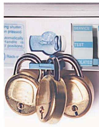
摇柄插孔挡板 可用3把挂锁锁定 (挂锁直径6mm 2 )
