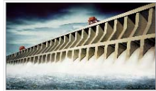
水力发电站 Hydraulic power station
